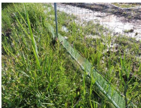
Photo 34: Barrière à amphibiens en doublement d'une barrière de chantier de type Heras
